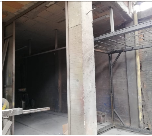
Fotografía No 4 área de aplicación de pintura
